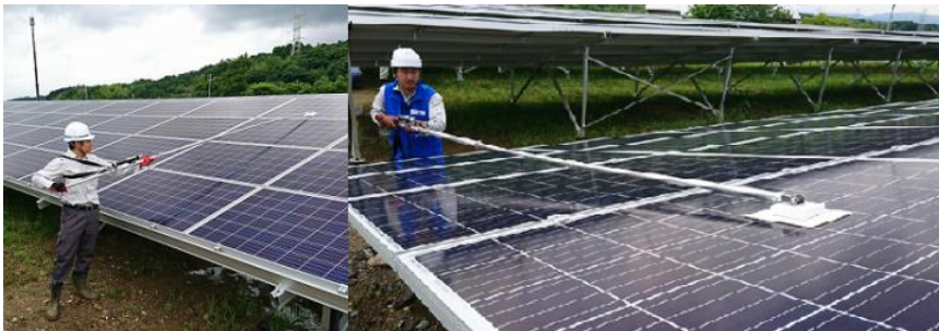
ソラメンテ-iS(SI-200)+Z/iS 連携キットにより探索信号を受信し故障パネル特定
