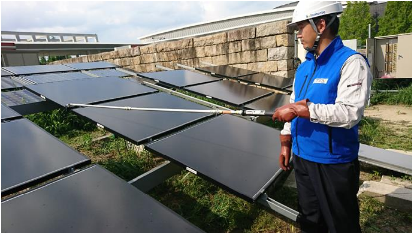
CIS 薄膜パネルの点検風景
