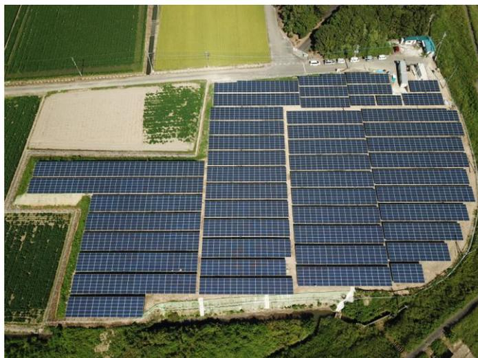
サンテックパワージャパン株式会社（本社：東京都新宿区、取締役社長 ガオ ジャン、以降サンテックパワーと表記）は 10 月 25 日、PHOTON JAPAN 合同会社（本社：東京都港区、代表者：前北正幸）が佐賀県武雄市に完成させた武雄太陽光発電所Ⅱに対して、サンテックパワー製の太陽電池モジュール 4,410 枚と、サンテックパワーが調達したファーウェイ社製パワーコンディショナ 32 台を納入したことを発表しました。当該太陽光発電所は、13,344.64 m<sup>2</sup>の敷地に、サンテックパワー製 325W の太陽電池モジュールが設置され、出力は 1,433.25kW となります。
