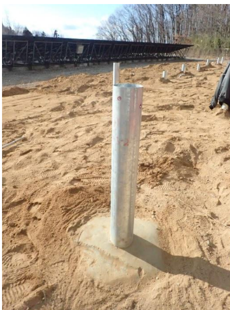
柱状改良杭に鋼管杭埋設
