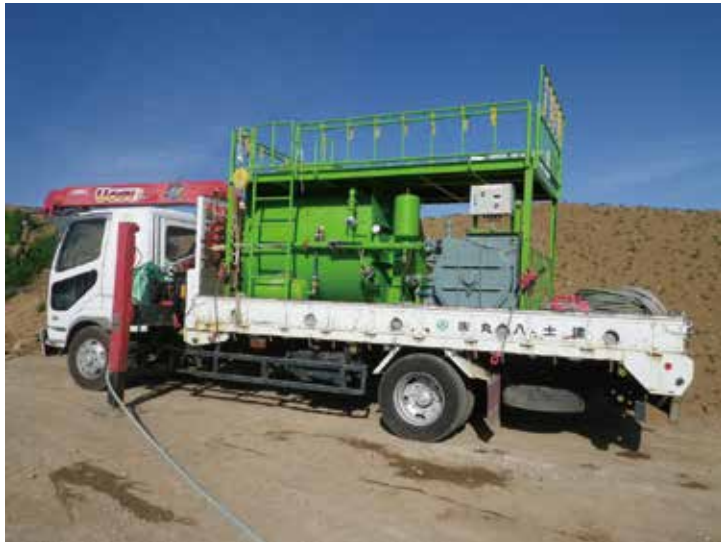
施工は種子吹付機(ハイドロシーダー)を使用
