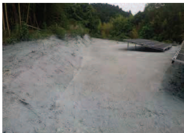
施工後 2 週間目の安定した状態
