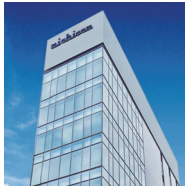
東京支店 / 電源センター / ユタカ電機製作所 TOKYO SALES OFFICE / Power Supply Center / YUTAKA ELECTRIC MFG. CO., LTD.
