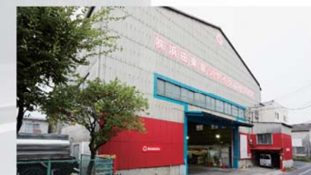
産業廃棄物処理施設、トラックスケール併設 ●処理設備 【破砕施設】(蛍光灯破砕機) 廃蛍光灯・廃電球類／【切断施設】廃プラスチック類、金属くず
