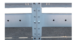
支柱・ビーム取付部
