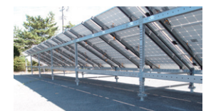
架台裏面構造
