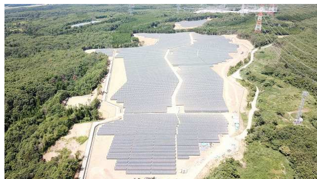
石川県志賀町 13.89MW 「石川県志賀町メガソーラー発電所（La Energía Ciervo Rojo）」 （太陽光パーク2合同会社様）
