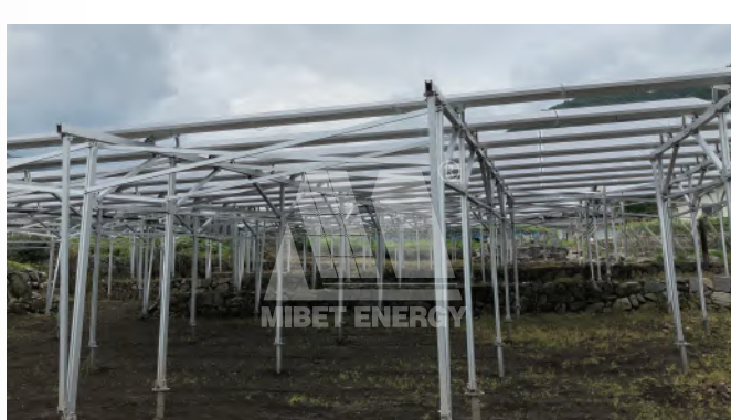
▲ 日本山梨県山梨市営農架台
