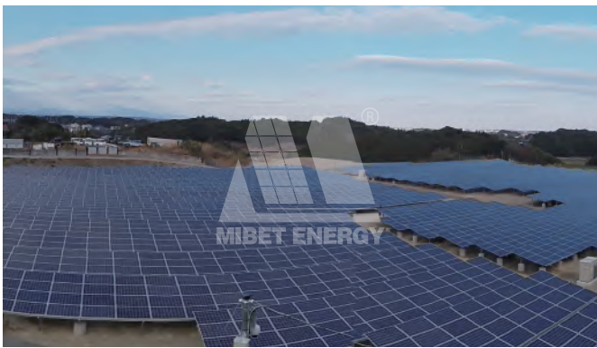
▲ 日本宮崎県 3.127MW
