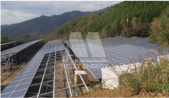
▲ 日本岡山県高梁市 1.068MW
