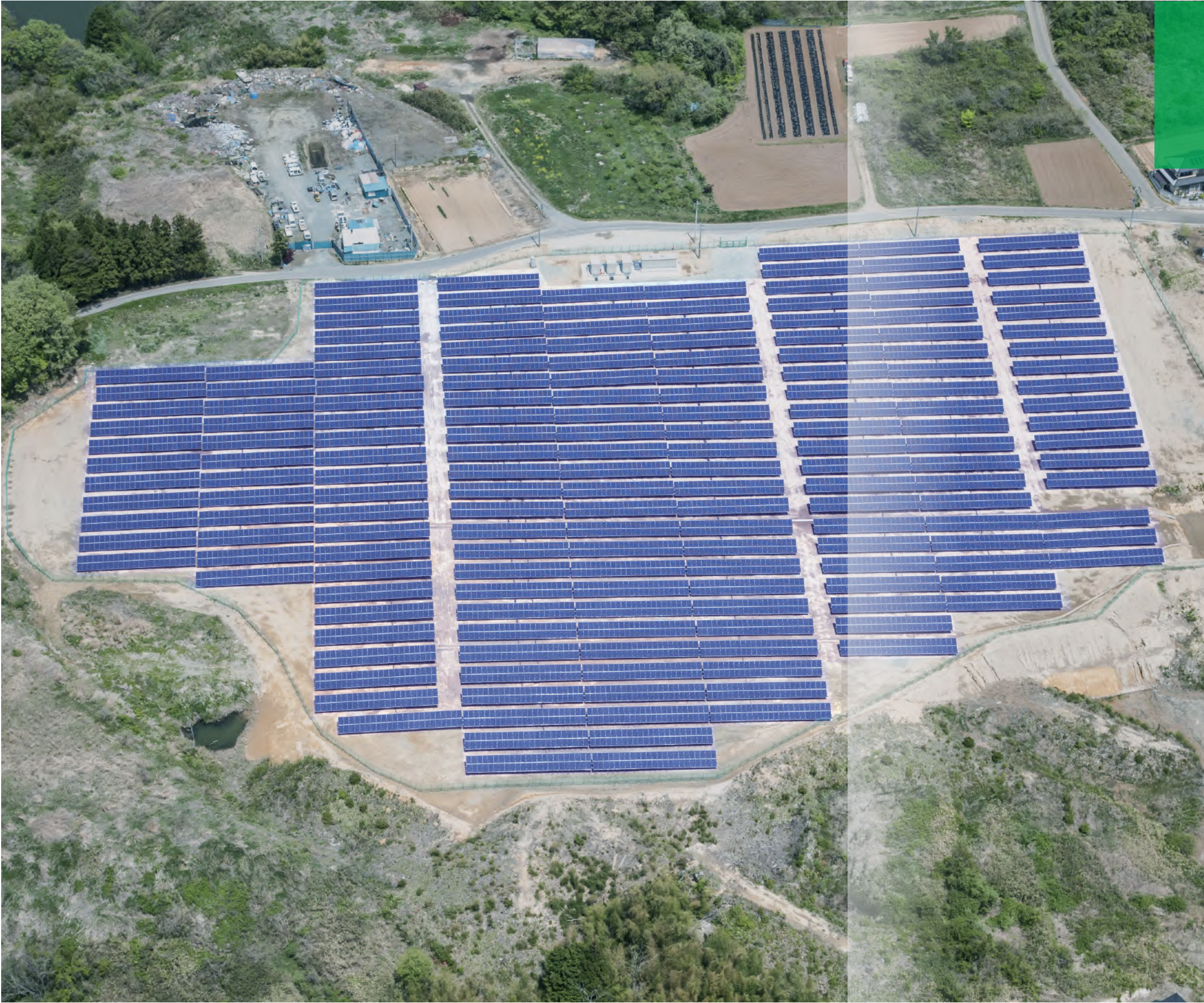
▲ 日本福島県相馬第一発電所 2MW
