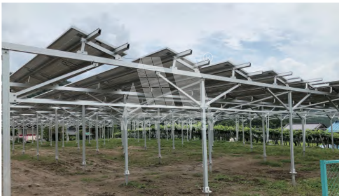
▲ 日本山梨県山梨市営農架台
