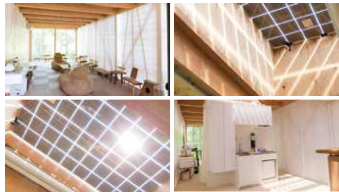
透明なグリッドの隙間から柔らかな自然光を取り入れることで、直射日光よりもさらに快適な空間に。
