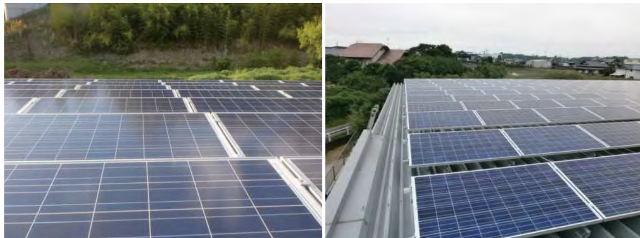
折り板屋根フック+三角架台
