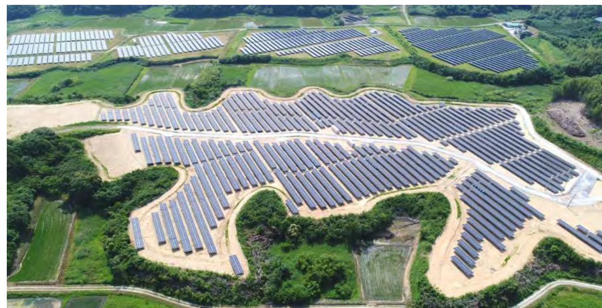
日本茨城県 容量:6MW
