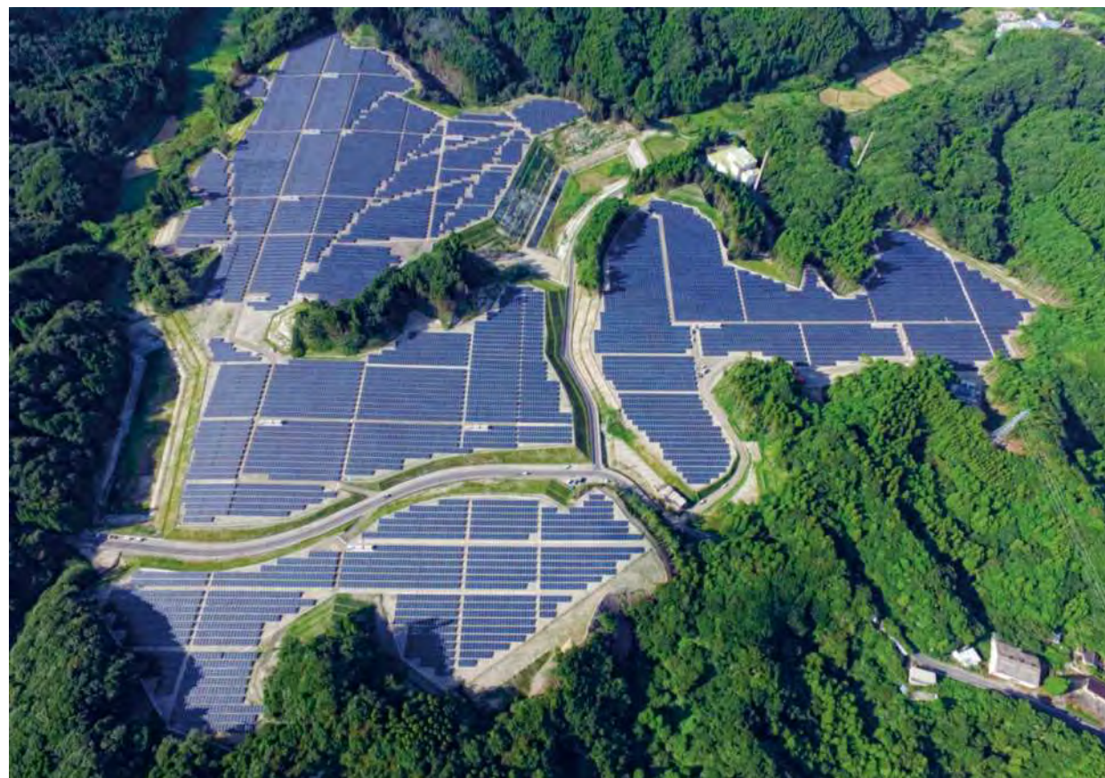
日本千葉 容量:22MW
