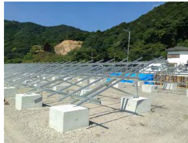
コンクリート基礎
