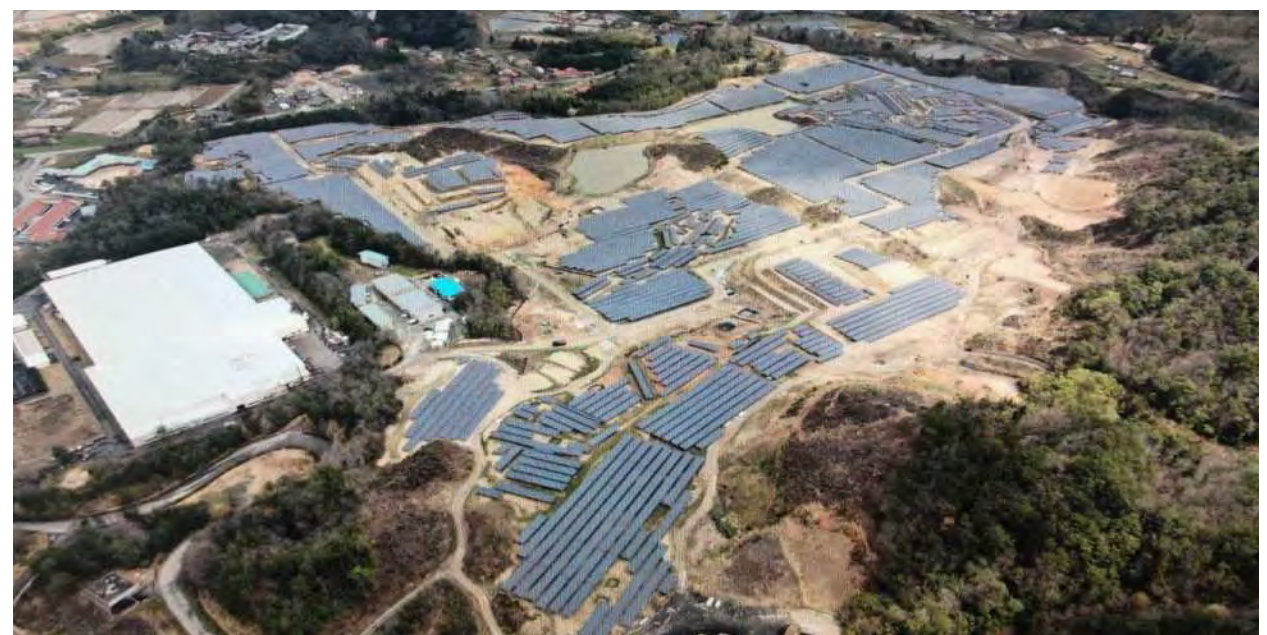
日本島根 容量:47MW
