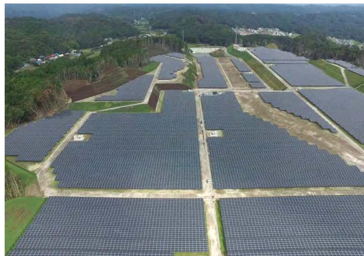
日本千葉 容量:30MW
