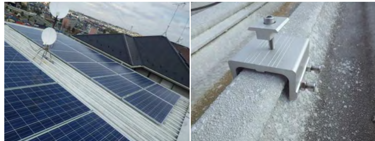
浸水屋根フック
