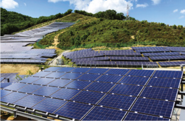
あえて方位にこだわらず、波打つ地面に沿って太陽電池を設置。真南に向けて設置したシステムとの発電量の違いをチェックしています。
