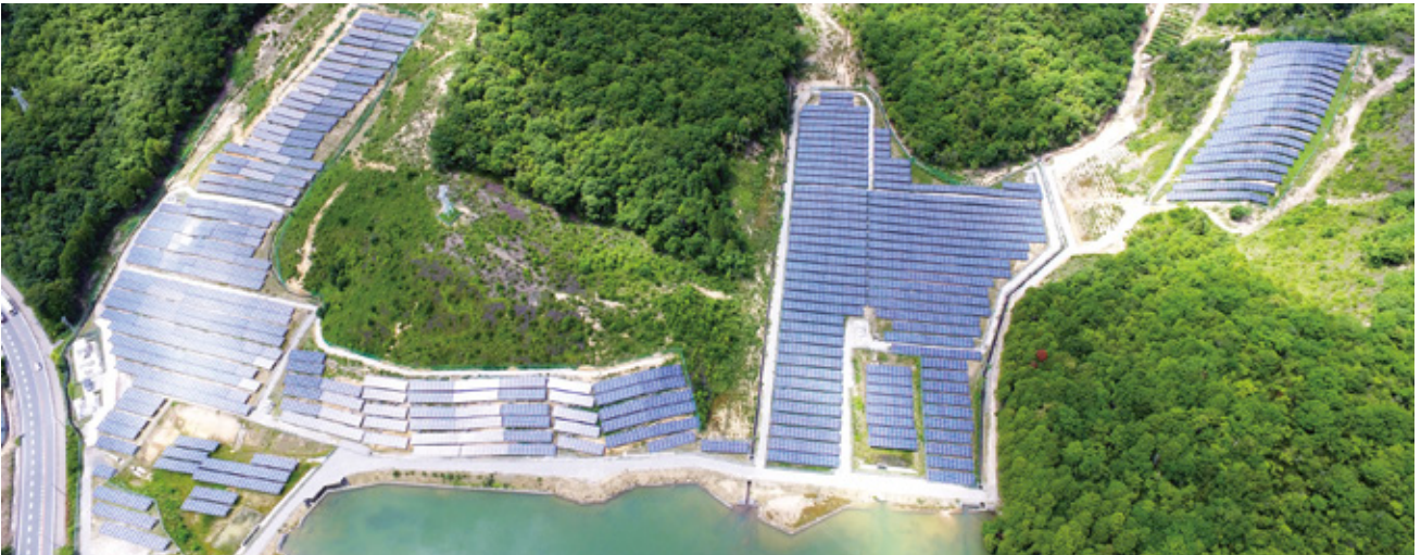
赤穂エネルギーパークは、実発電環境で分散型太陽光発電システムを鍛え上げるためのテストフィールド。「分散せよ!」を実践しています。
