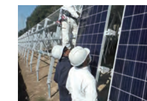
前面に防風板を兼ねた パネルを設置
