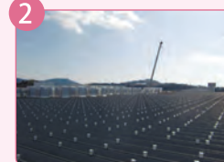
金具取付け完了
