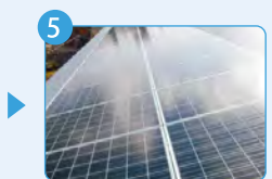
パネル設置完了
