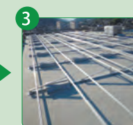
横ラック・ウエイト設置
