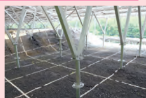
スクリュー基礎の長さ調節にご使用下さい。 2種類をご用意しております。(H=500mm、H=1000mm) 凸凹の土地や、架台の高さの調節に最適な金具です。 500mm & 1000mmの長さは岡山から即納可能です。
