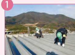
凸部に金具を取付け
