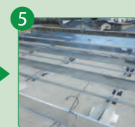
架台設置完了
