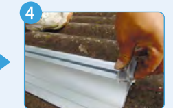
接続金具取付け
