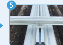
横ラック設置
