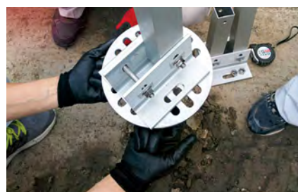
調整幅が広くなり、架台施工のスピードアップ
