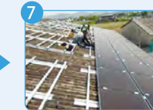
パネル取付け
