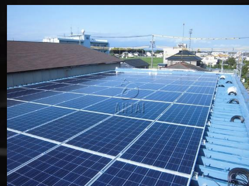
折板屋根直付け工法
