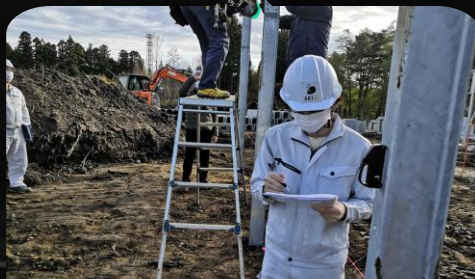
施工前、施工中の現地指導
