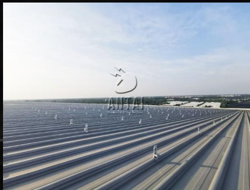
折板屋根ラック工法
