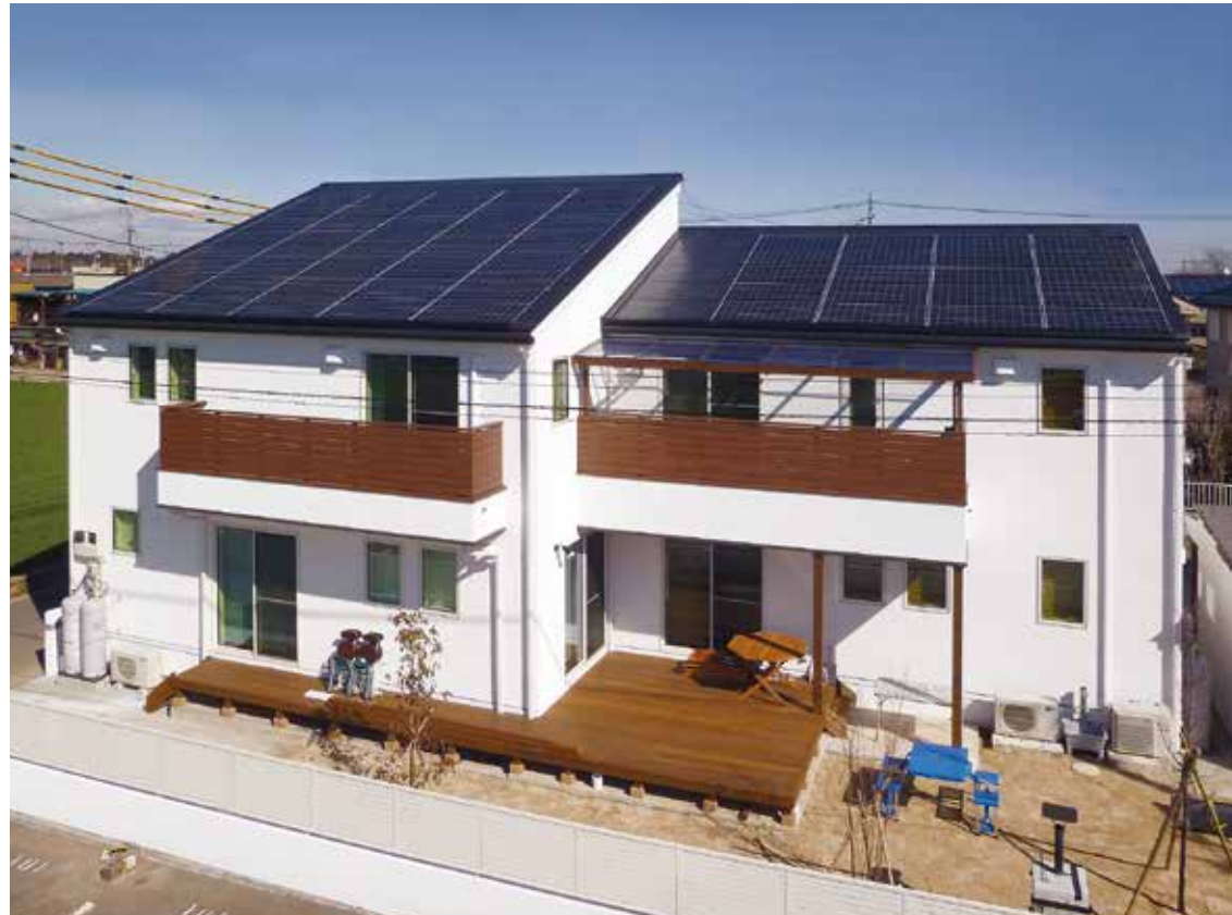
新築 12.6kW 茨城県古河市
