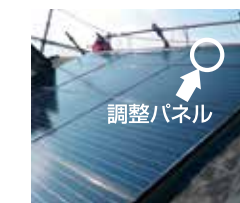
◀調整パネルの設置 パネル以外の余った外周部分を寸法調整用の調整パネルで全面フラットに仕上げます。
