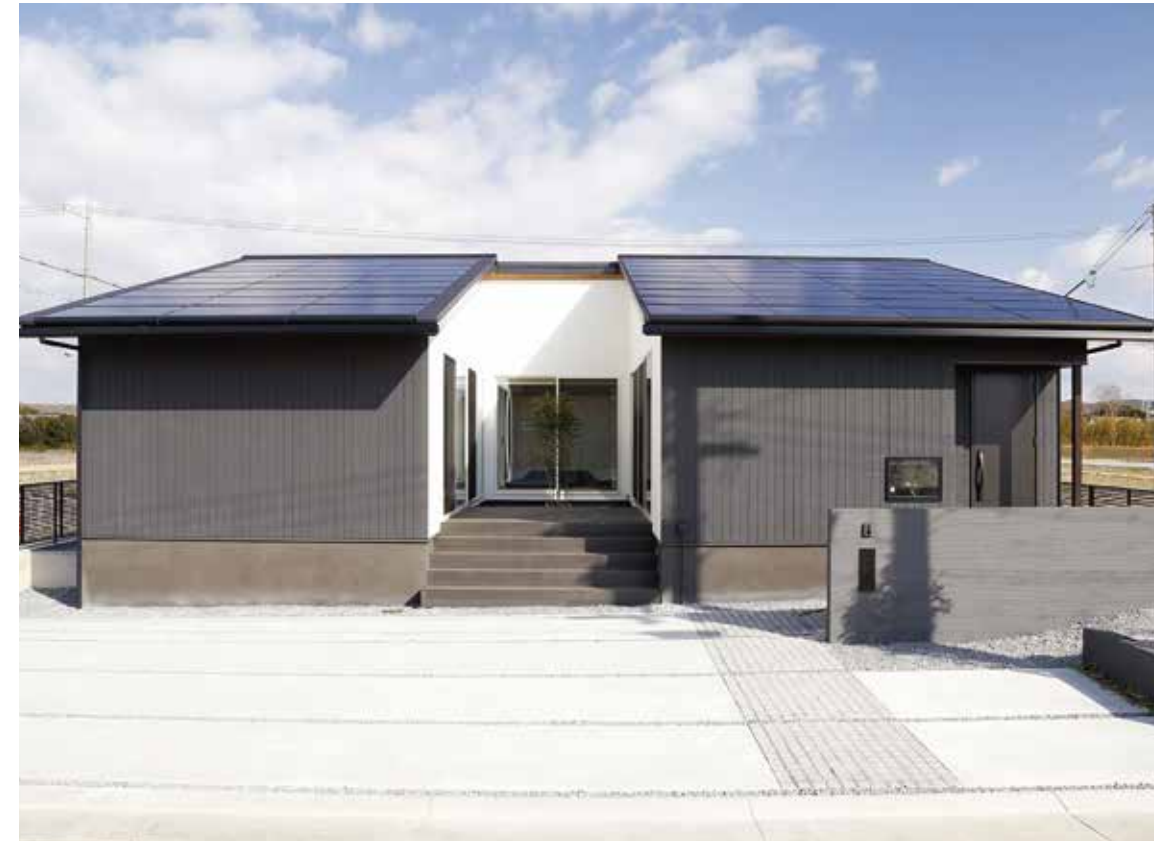
新築 12.285kW 兵庫県神戸市
