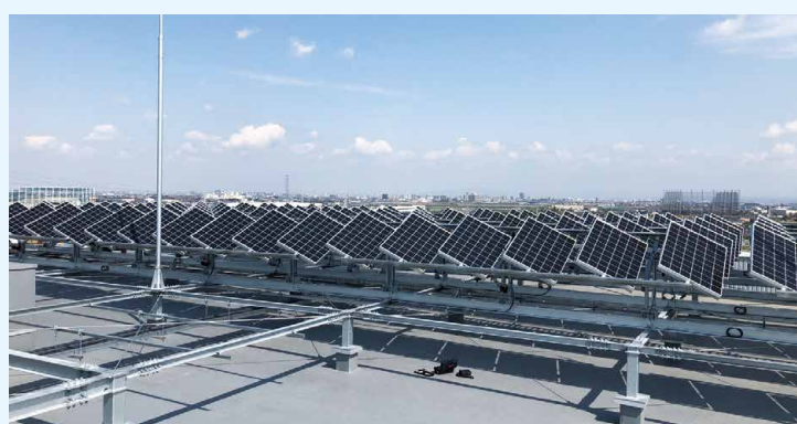
「太陽光自動追尾架台」は太陽の動きに合わせて発電パネルを可動させることが可能。発電量は固定型と比べ40%増を実現している。
