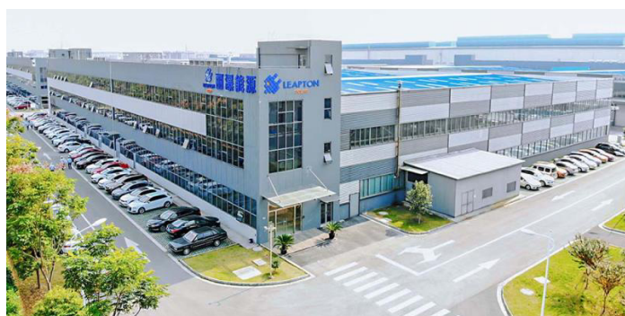
▶現在稼働中のモジュール工場(中国常熟市)
